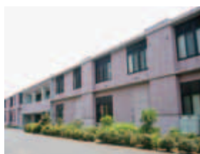
かわさき新産業創造センター
